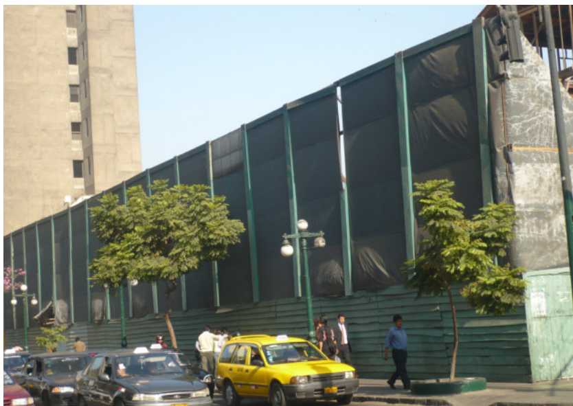
Figura 7. Fachada del inmueble por el lado de la avenida Emancipación (2008). Fuente: Municipalidad Metropolitana de Lima, Prolima, exped. 5055-015, 2000.
