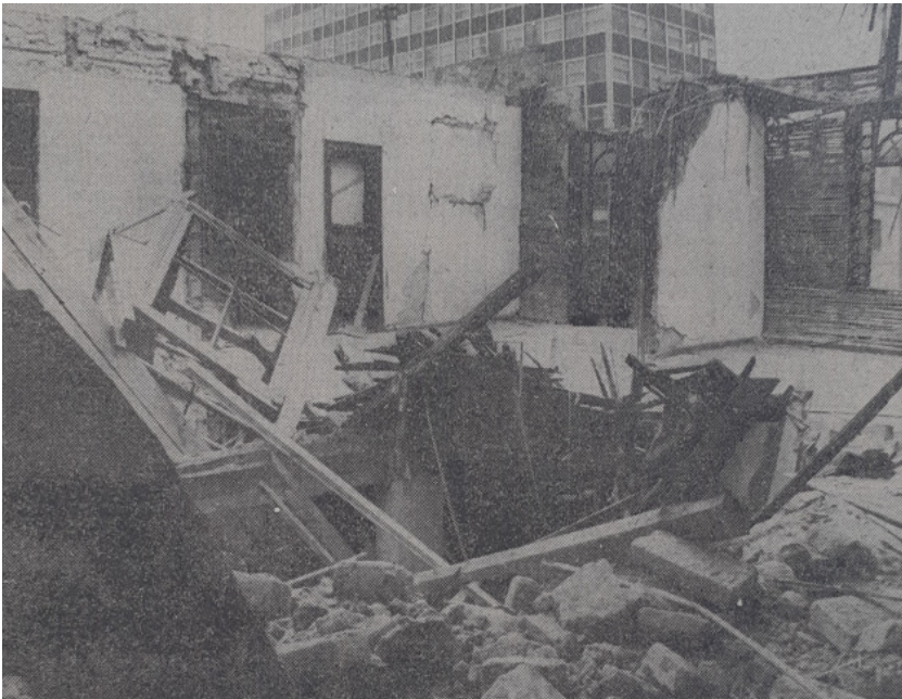
Figura 4. Vista de la demolición del techo de la casa. Cabrera Luces, Ó. (1976b, 18 de noviembre). «Suspenden demolición de finca ruinososa». La prensa , p. 5.
