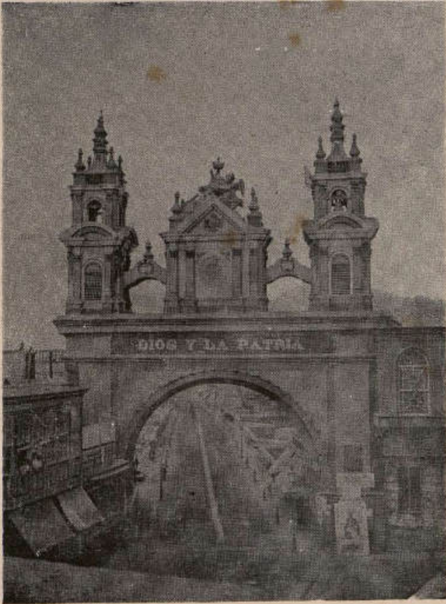
Fig. 1.—EL ARCO DEL PUENTE. (Fotografía de 1872).
