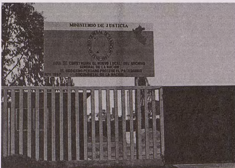
Lugar donde se construirá el nuevo local del Archivo General de la Nación, en un área de 5,198 m 2 , ubicado en la Urb. Santa Patricia, distrito de la Molina.
