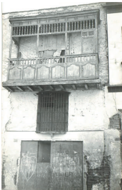
Detalle de la fachada del inmueble del Jr. Ancash 935-937.
