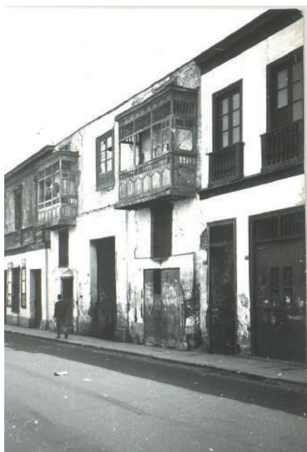
Fachada del inmueble Jr. Ancash 935-937.
