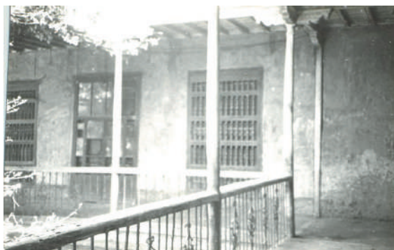
Galería del segundo nivel.
