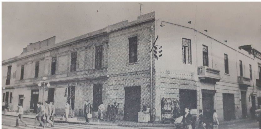
Figura 2. Vista de la fachada de la casa. Fuente: «La casa de Castilla: una verdadera ruina», Oiga , n.º 604, 17 de octubre de 1975, p. 15.
