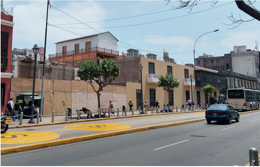
Figura 11. Vista del inmueble por el lado de la avenida de la Emancipación (2025). Fuente: archivo fotográfico del autor.
